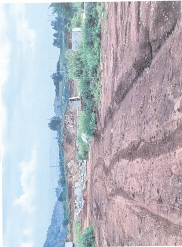
เปิดหน้าดินและเริ่มตัดเสื่อค้ำหินอ่อน(หินอ่อนไม่มีคุณภาพ)
